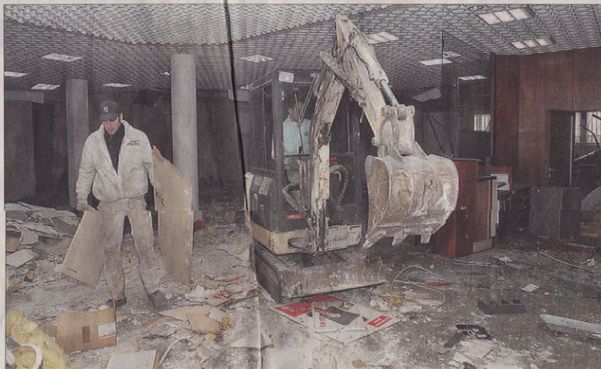
Der kleine Abbruchbagger macht die Vorhut. Er zerlegt die massiven Bestandteile der alten Schalterhalle. Anfang Mai rückt schwere Baugerät an, das das Gebäude wegräumen wird. (WR-Bilder: Rüdiger)
